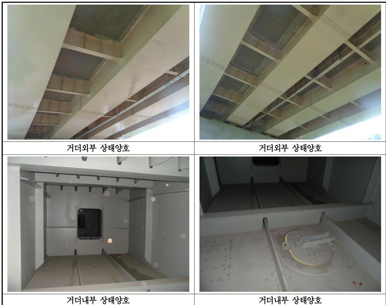
【사진 18.3.5】 거더 손상현황
