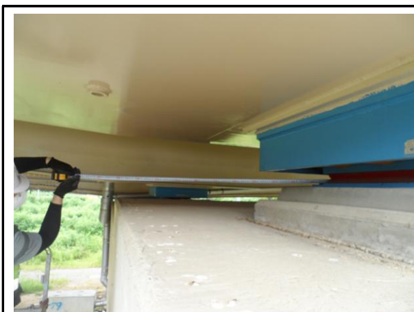
받침장치 연단거리 측정
