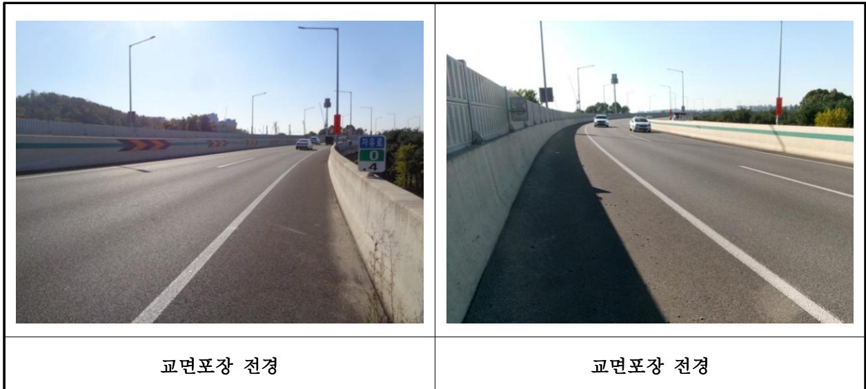
【사진 18.3.19】 교면포장 전경
