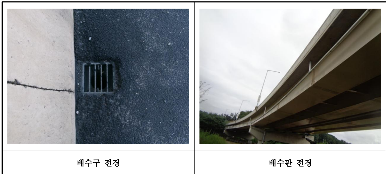
【사진 18.3.21】 배수시설 전경
