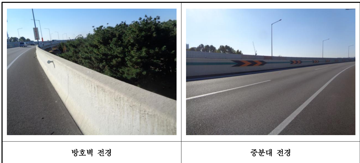
【사진 18.3.23】 방호벽 및 중앙분리대 전경
