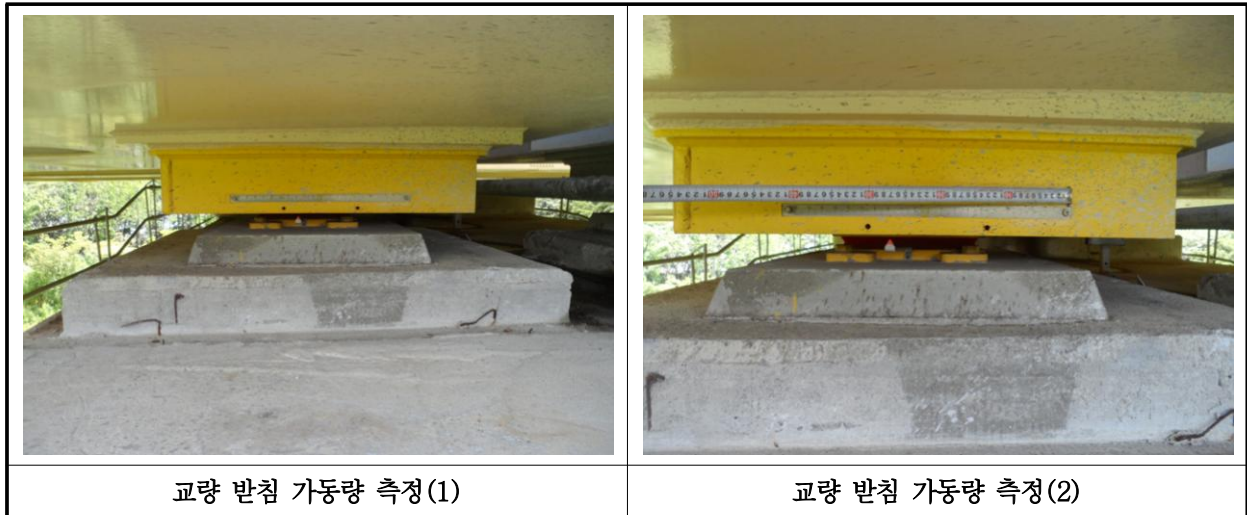
【사진 18.3.15】 교량받침 이동량 측정
