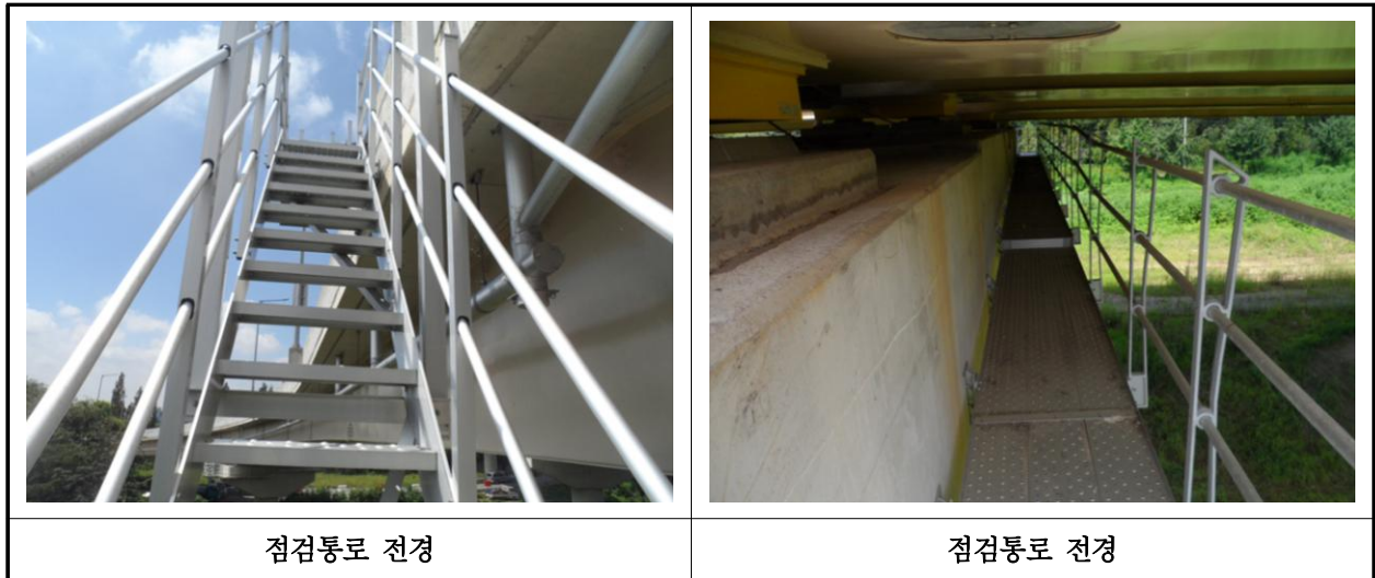
【사진 18.3.25】 교량 점검시설 전경
