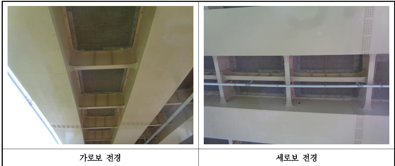
【사진 18.3.6】 가로보 및 세로보 전경
