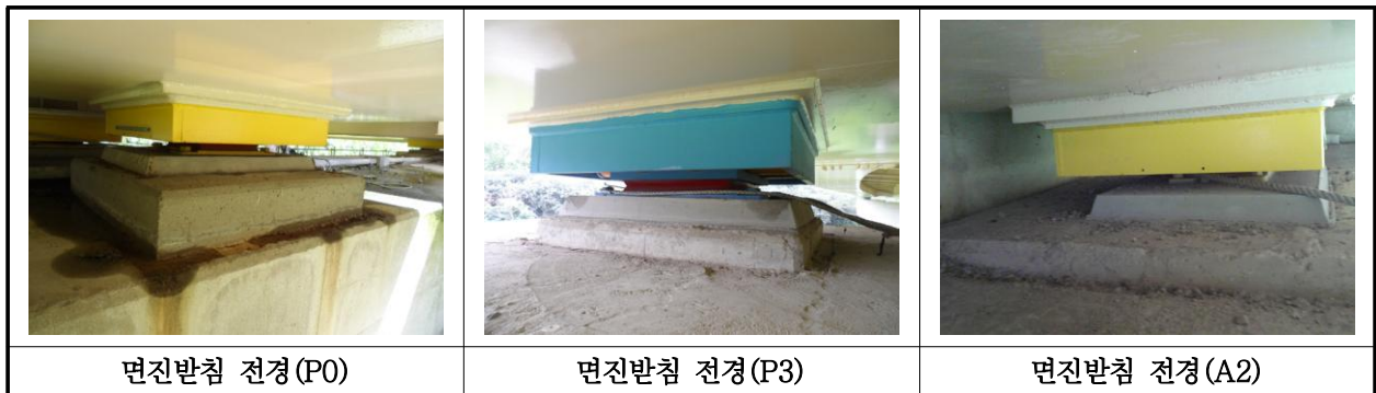
【사진 18.3.12】 교량받침 전경
