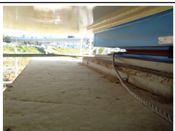
받침장치 연단거리 측정
