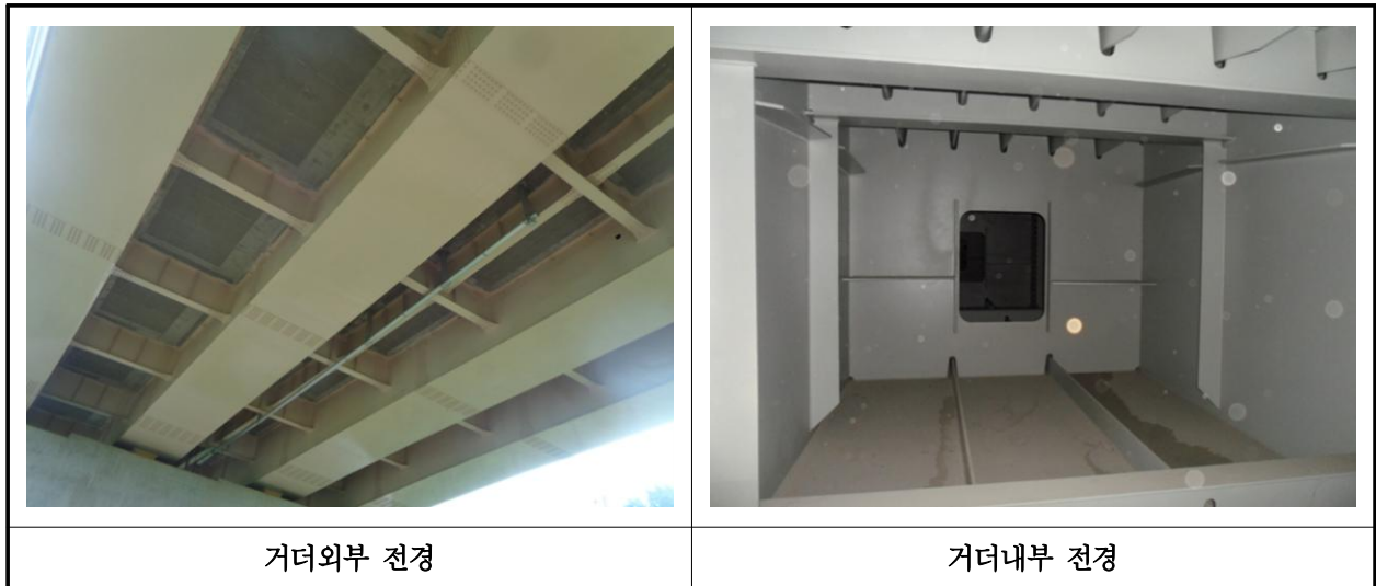
【사진 18.3.4】 거더 전경
