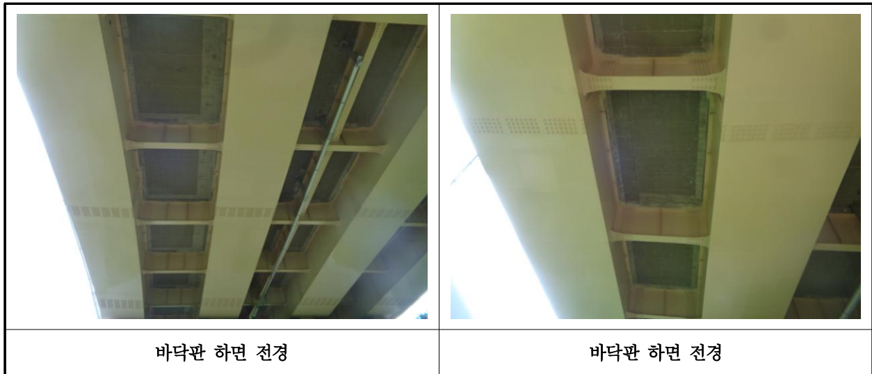
【사진 18.3.2】 바닥판하면 전경
